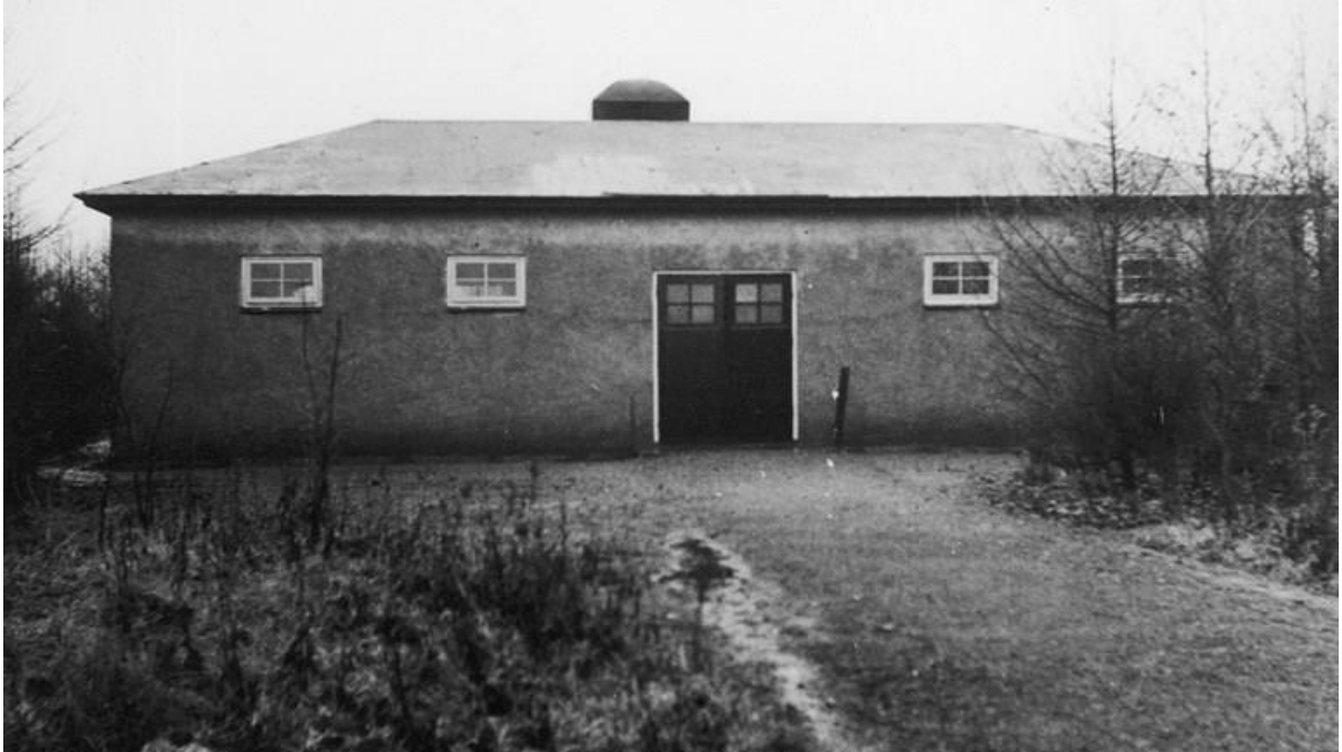
Het afgebroken crematorium van voormalig kamp Westerbork. Bron: Herinneringscentrum Westerbork
