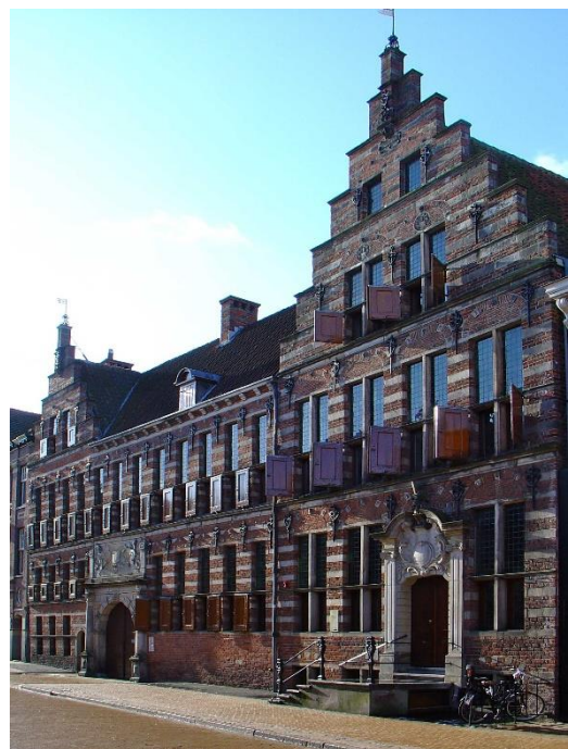
Arrondissementsrechtbank, Groningen. Bron: https://rijksmonumenten.nl/
