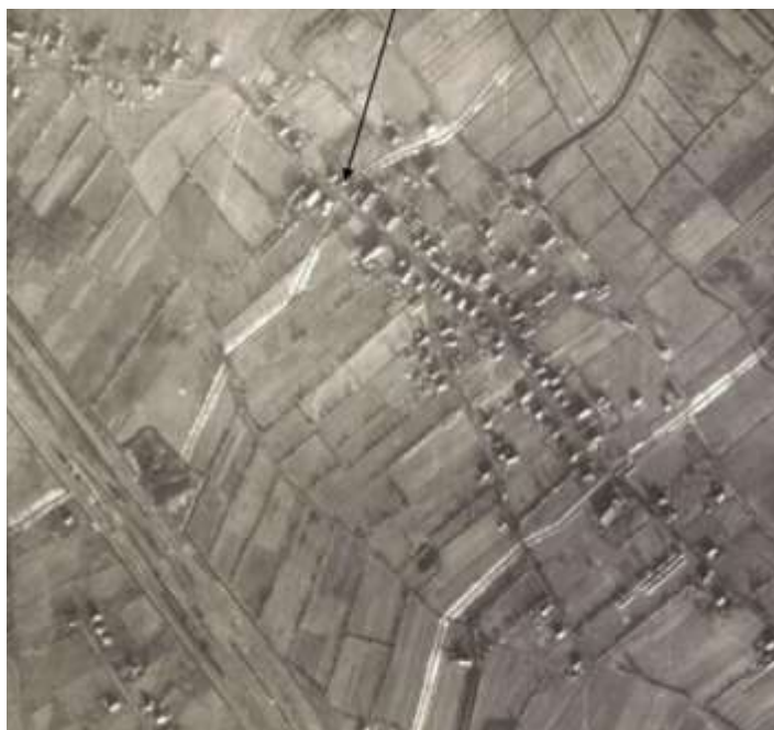
Luchtfoto van Onnen gedateerd 29 november 1944, met het treinemplacement en tankgrachten aan de noord en zuidkant van Onnen
