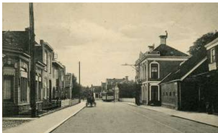
Beeld van de Rijkstraatweg ca 1935. Rechts het grote huis van notaris Scato Lohman. Links op de voorgrond Rijksstraatweg 196 (nu Flashman) en direct daarnaast het door Vijfschagt gerealiseerde pand Rijksstraatweg 198 met de voorgevel conform de bouwtekening van Schut en Snijder
