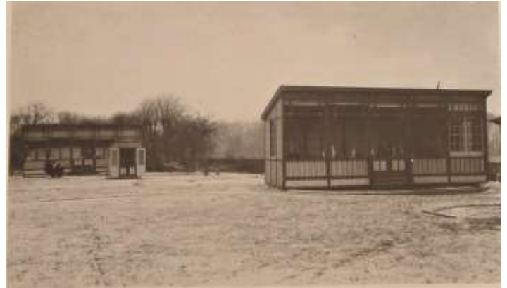
Het lighallencomplex in Helpman. De lighallen waren draaibaar en konden worden afgestemd op de stand van de zon en van de windrichting
