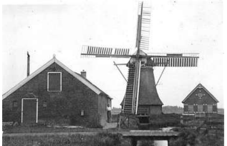
De in 1862 gebouwde poldermolen met links de molenaarswoning en rechts het in 1913 bijgebouwde stoomgemaal.
