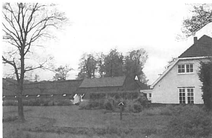
Het woonhuis en de schuur anno 2017
