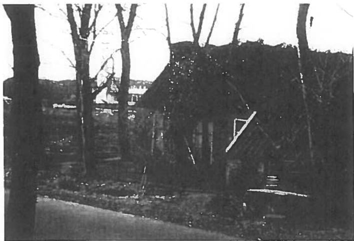
Meerweg 233 Paterswolde. Vlak voor de afbraak in 1948. Met links van het huis de uitkijktoren
