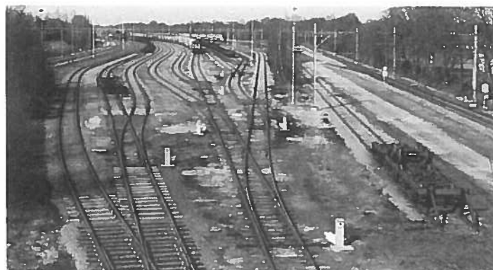
Overzicht van het rangeerterrein
