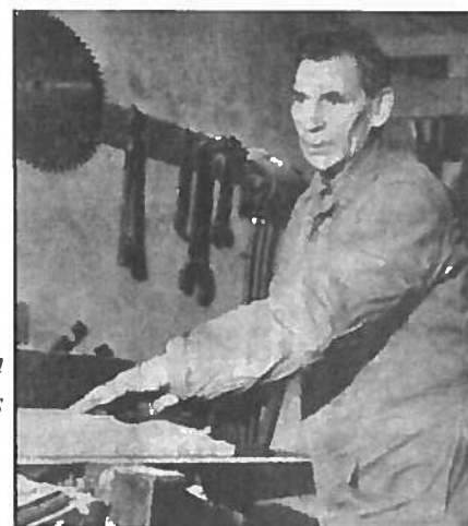
Afbeelding 5: Geert Bazuin sr. in de timmerwerkplaats van Wieringa
